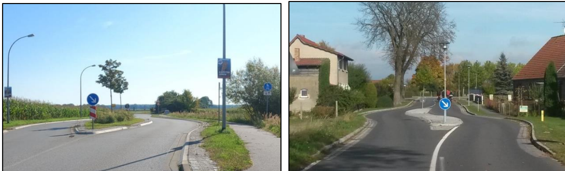
Abb. 17 Beispiele Ortseingangsgestaltung mit Fahrstreifenversatz
